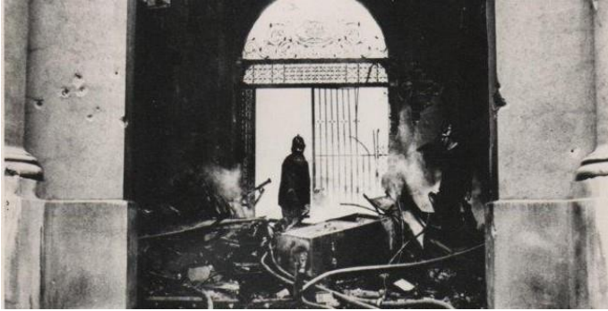
Imagen del incendio del Palacio de Gobierno
